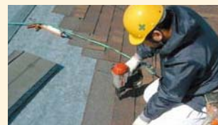
野地に届く長さの釘で本体をしっかりと固定します。
