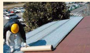
片面粘着式のルーフィング材を既存の化粧スレートの上から置いていきます。
