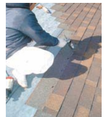
セメント点づけ(仮止め)
