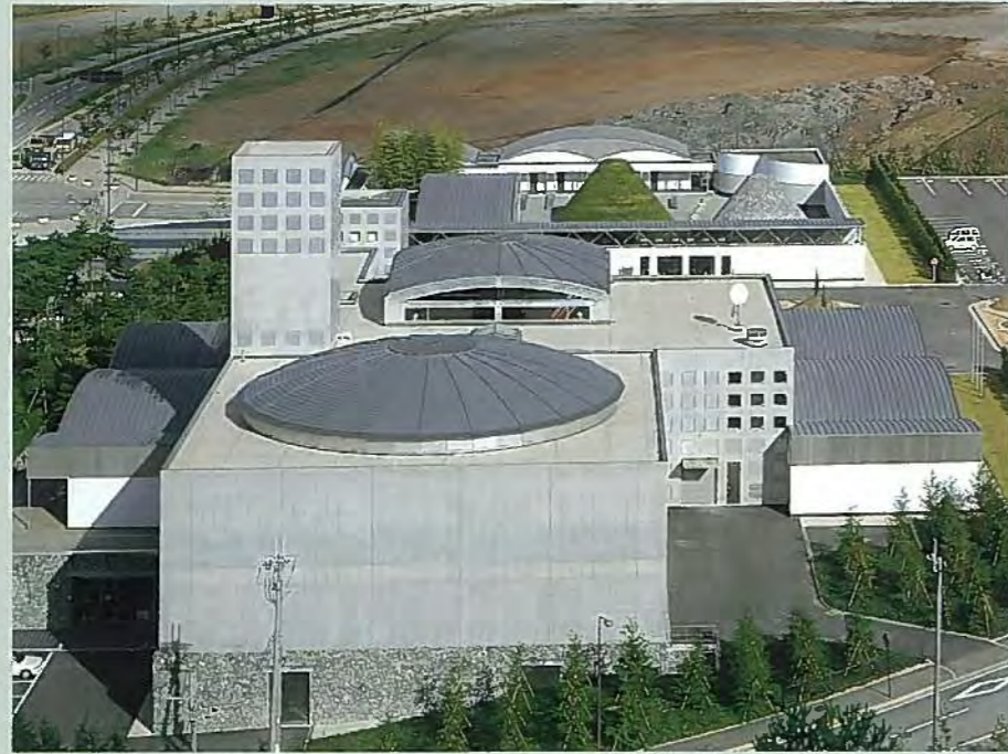
■兵庫県立先端科学技術支援センター ●設計/磯崎新アトリエ+設計組織 A・D・H+ピーター・ウォーカー・ウィリアム・ジョンソン・アンド・パートナーズ ●施工/竹中工務店、北村工務店、新井組
