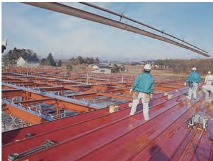
レッカーによる荷揚げ
