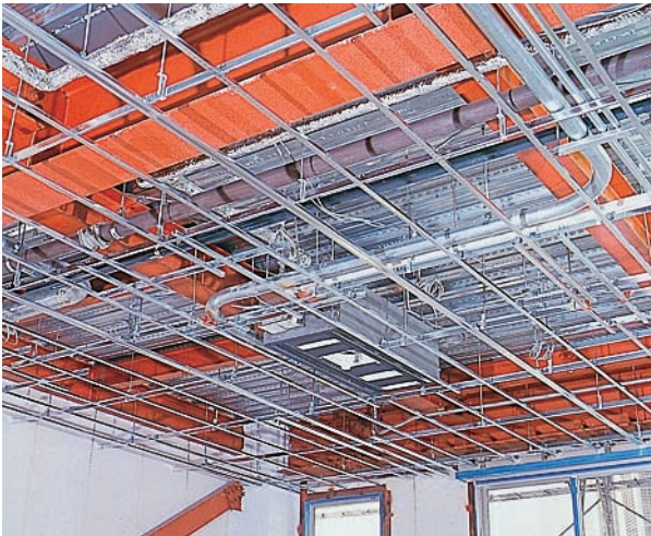
天井下地施工例
