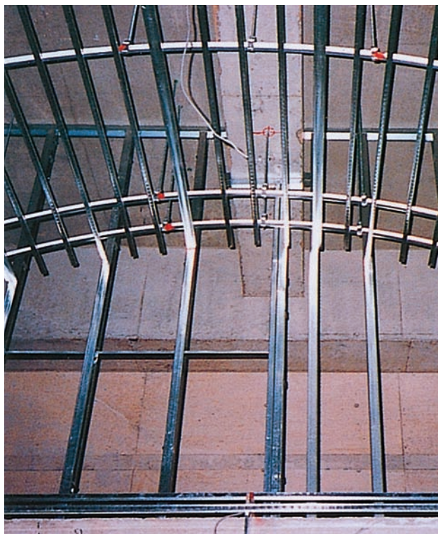
変形天井施工図
