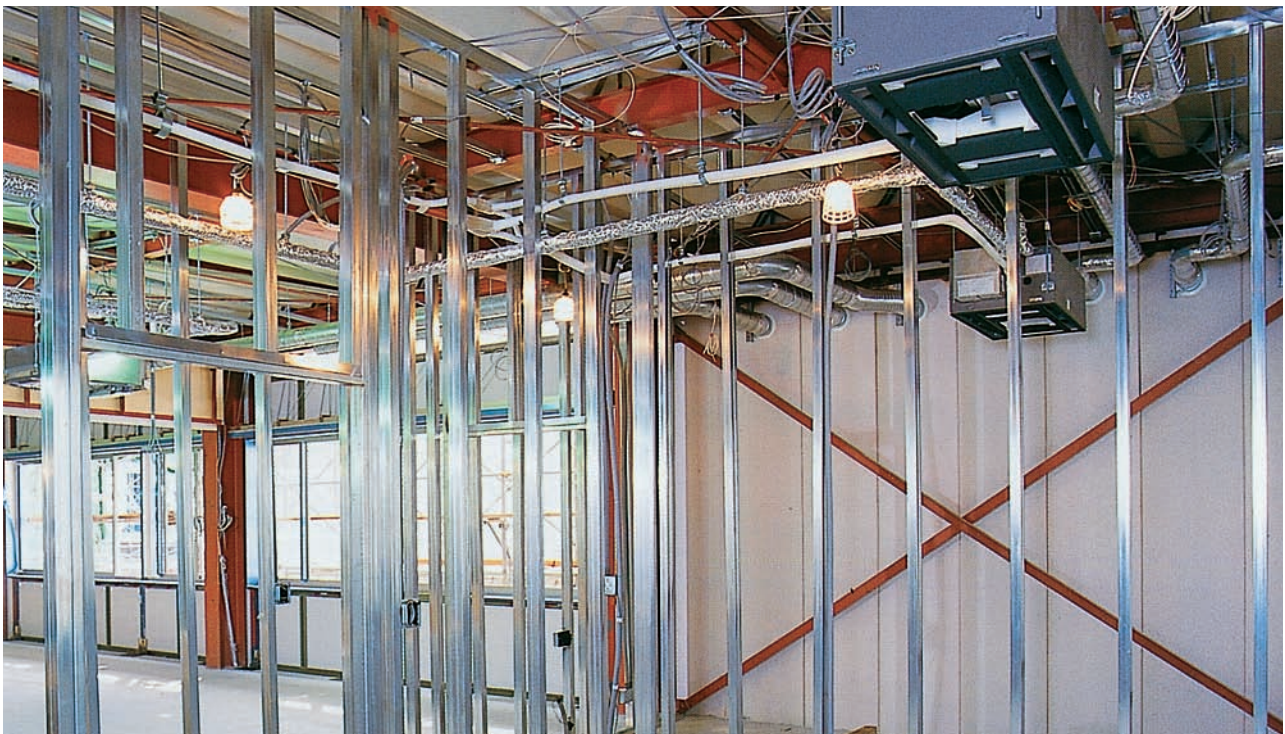
間仕切施工例（角・スタッド）
