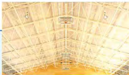
縦ジョイナー最長L=3mまで母屋スパンは3m以下でお願いします。
