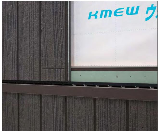
※縦張り釘留め用補助部材を使用した場合、上の写真のように補助部材の一部が見えます。ご購入前にご確認いただきますようお願いいたします。
