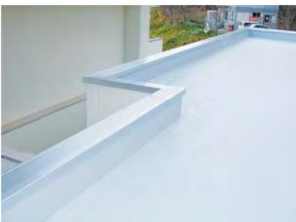
横引き樋補強鋼板納まり
