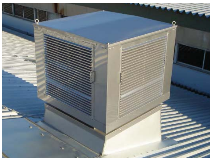
屋上取付け 折板屋根
