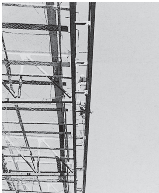
適度な感覚で受け金具を取り付ける
