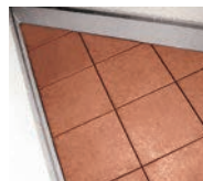
変形バルコニーの端部
