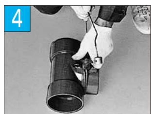
アルミコマ側のワイヤーを強く引張り、固定具を十分締付けたあと、蝶ナットでワイヤーを固定します。
