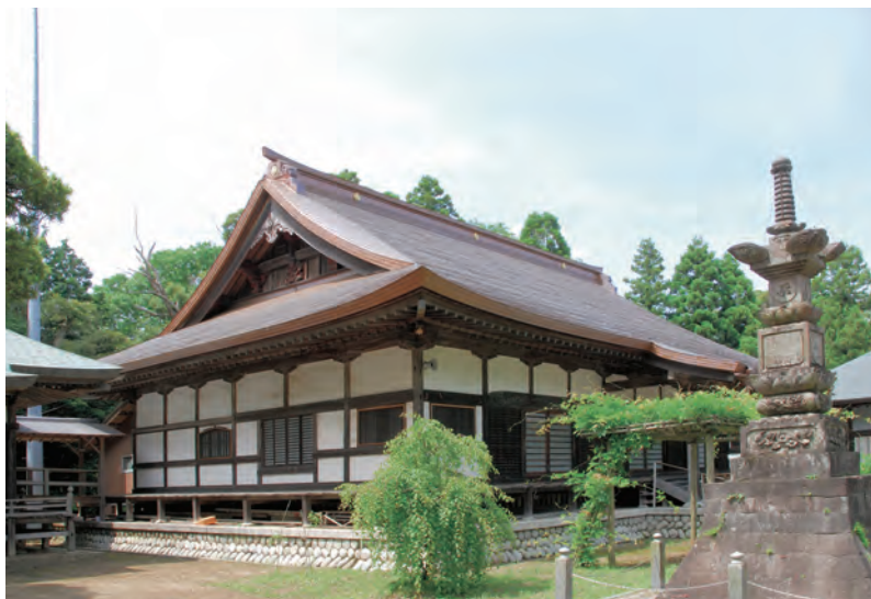
千葉県 屋根:本掛一文字(銅) HT-131形 みの甲板 HT-131形(特注品)
