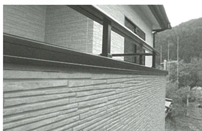
笠木施工後の完成写真 笠木にスッポリ隠れます。
