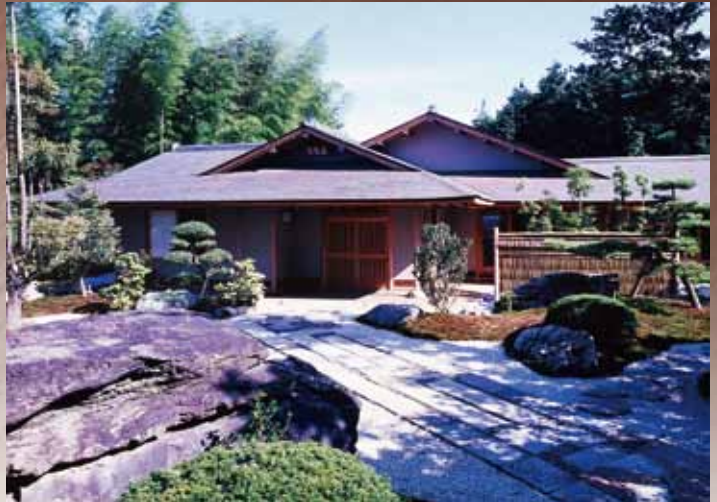
■伊勢の郷(三重県伊勢市) 材質:銅板 ●設計・施工/(株)新井組
